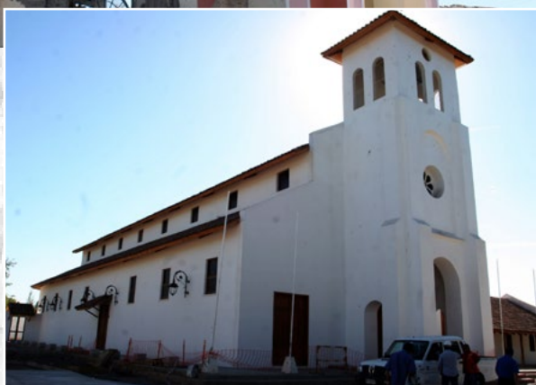
Un antes y un después, que dejó con alegría y esperanza a la comunidad fue la reconstrucción de la Iglesia de Chépica.
