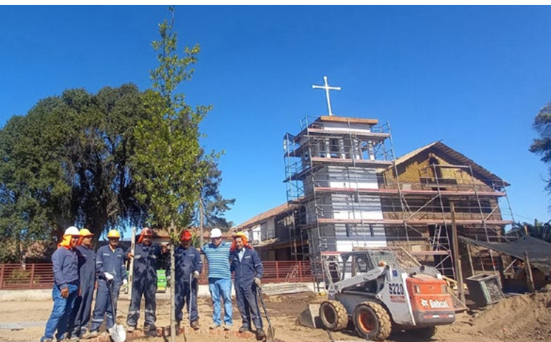
Obras presentan un gran avance en Codegua.
