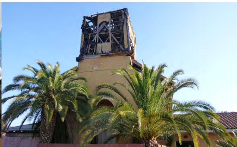
Torre de la Iglesia de Coinco.
