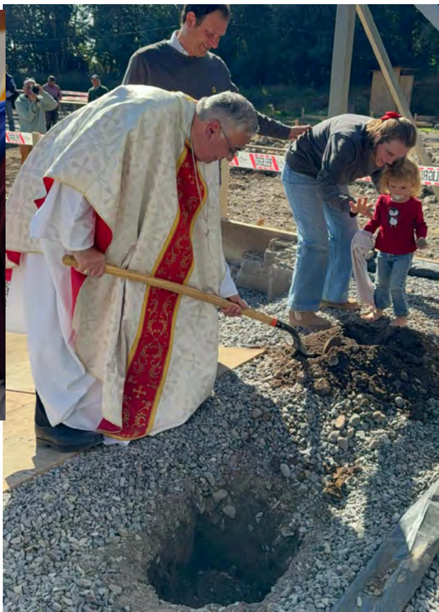
En mayo de 2025 el obispo de Rancagua puso la primera piedra de la obra.
